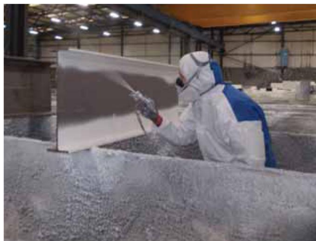
Нанесение Interchar® 2090 на балку
